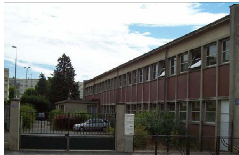
Vue de l'existant
