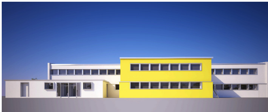
Vue de la façade Nord
