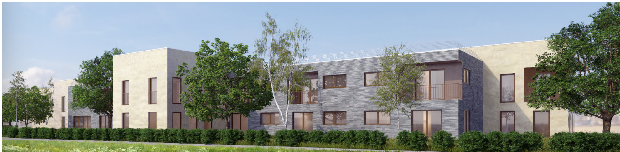
Vue depuis le Sud Ouest
