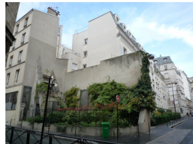
La dent creuse existante
