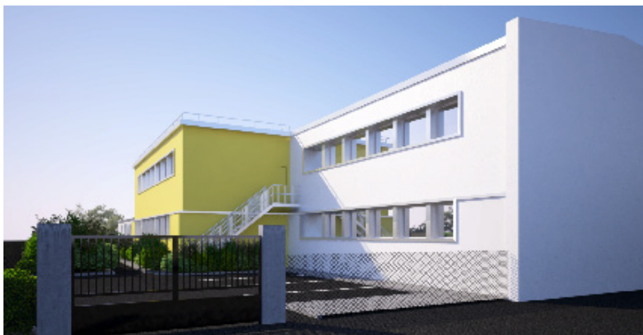
Vue de la façade réhabilitée et de l'extension
